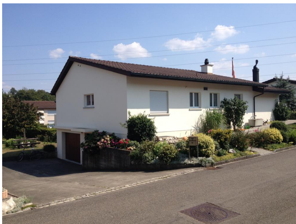
Nordfassade, Blick von Rosenstrasse mit Garagezufahrt, Eingang
