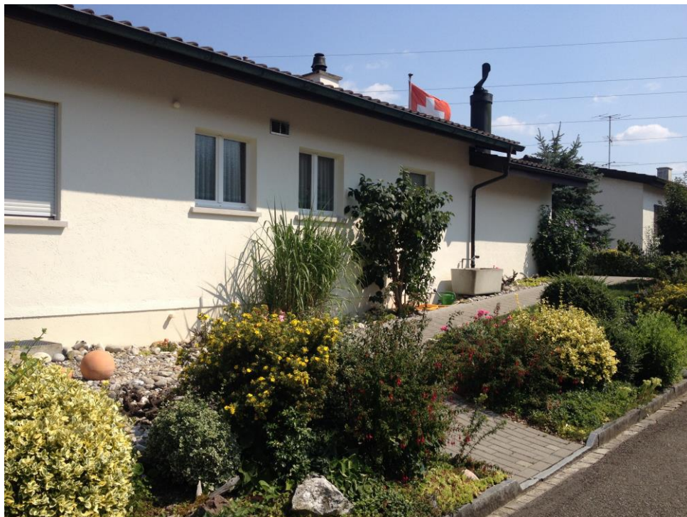
Ansicht von Rosenstrasse mit rollstuhlgängigem Weg zum Sitzplatz
